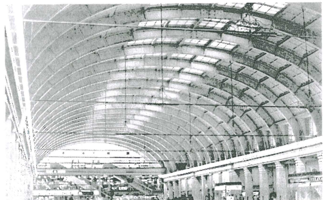
9 Bahnhofshalle in Stockholm (Baujahr 1925/Konstruktionsprinzip Hetzer)
